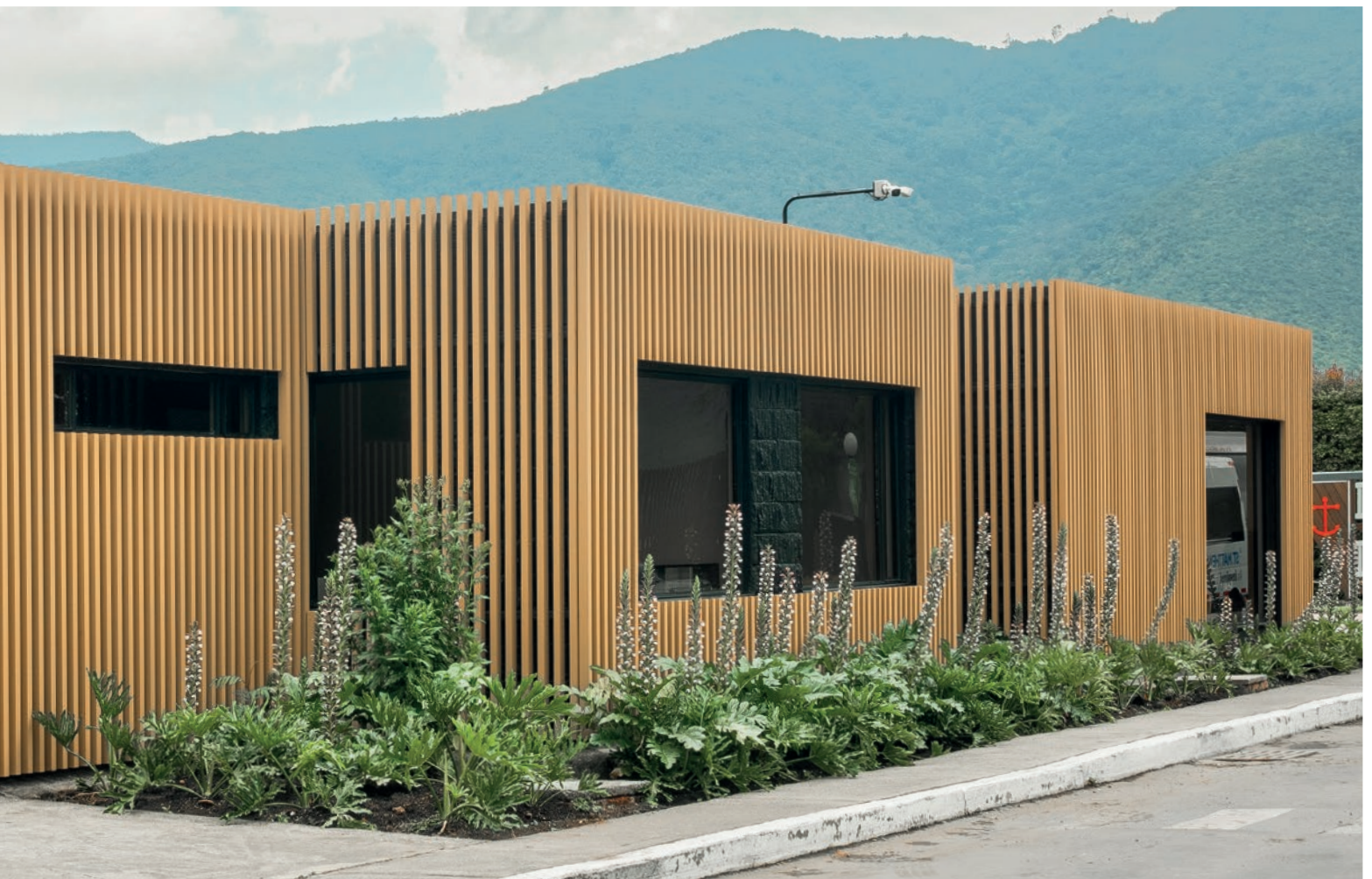
Colegio San mateo Apostol, Arkowood H, Sanmiguel Arquitectos, Colombia
