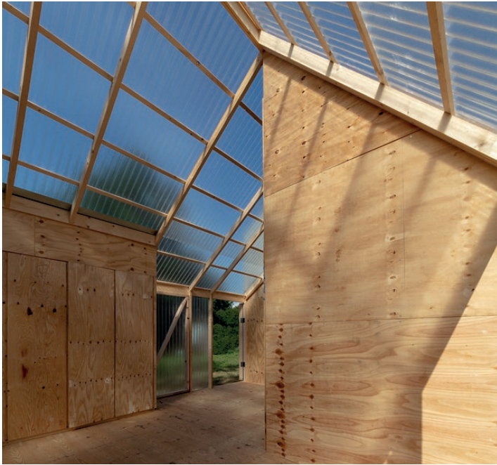
Residencia privada, Teja Ondulada P3, Colombia
