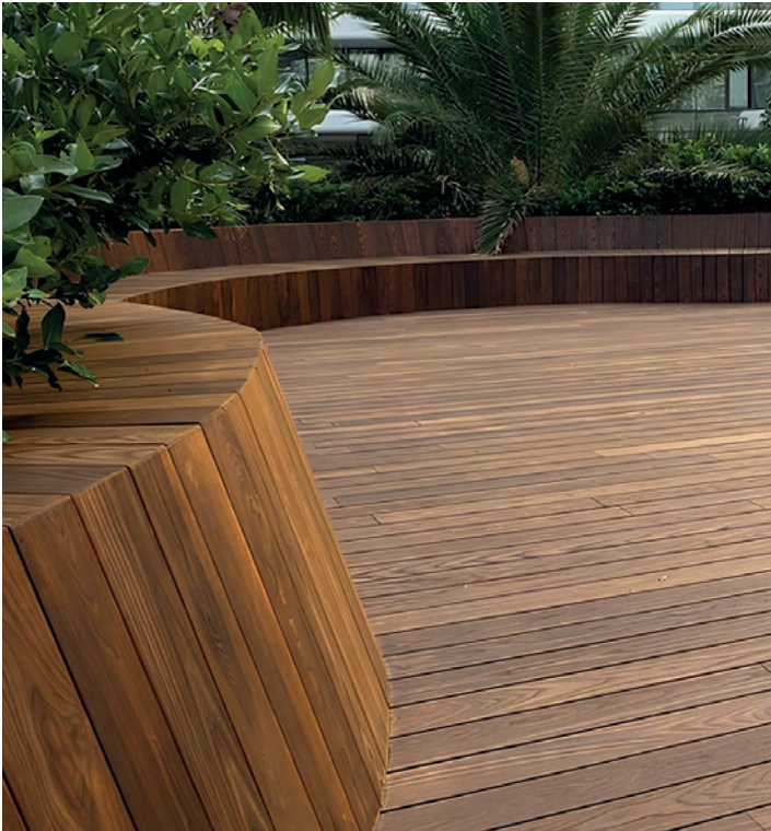
Lugar público, Thermowood deck, México
