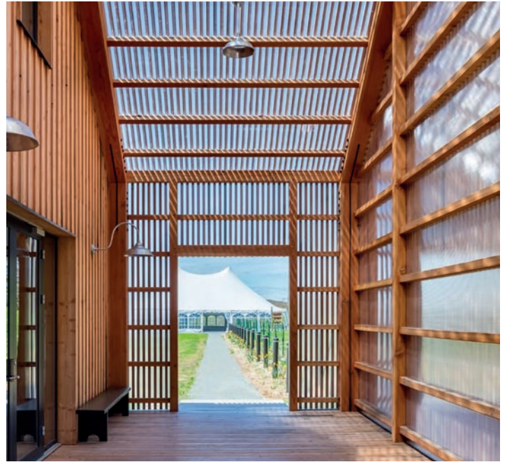
Residencia privada, Teja Ondulada P3, Colombia
