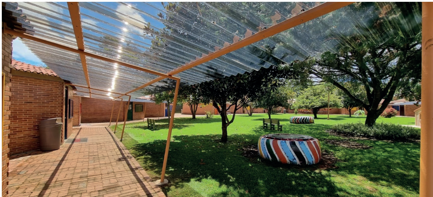
Colegio Gimnasio del Norte, Teja Ondulada P7, Colombia
